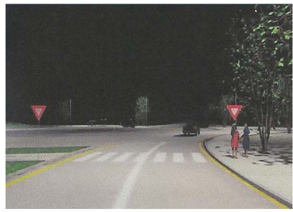
Iluminación de rotonda moderna con postes laterales
