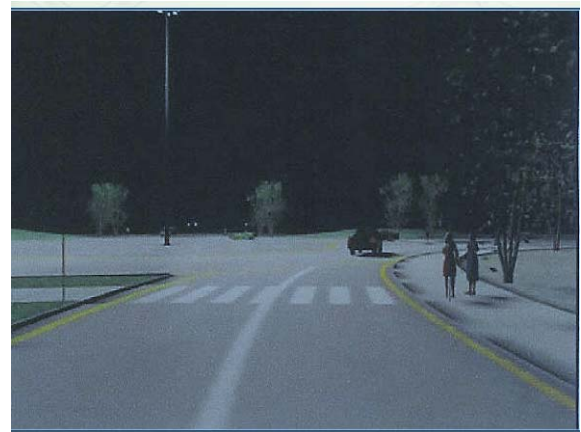
Iluminación de rotonda moderna con mástil central
