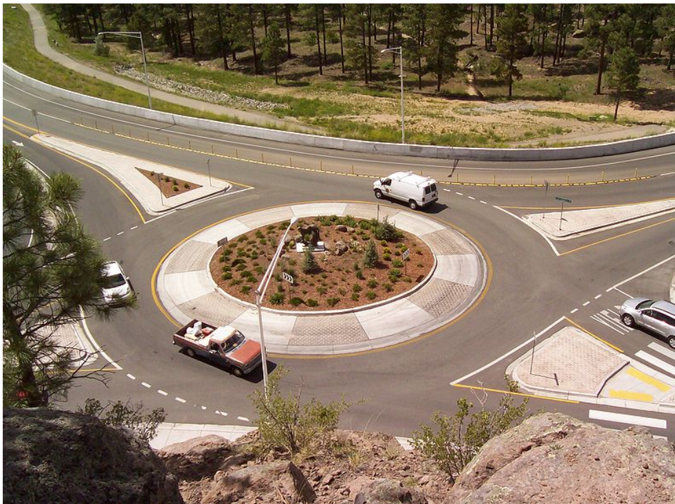
Figura 5.45 Elementos geométricos de una RM
