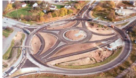
Figura 5.46 Diferencia de diámetros en una conversión de un CT en una RM
